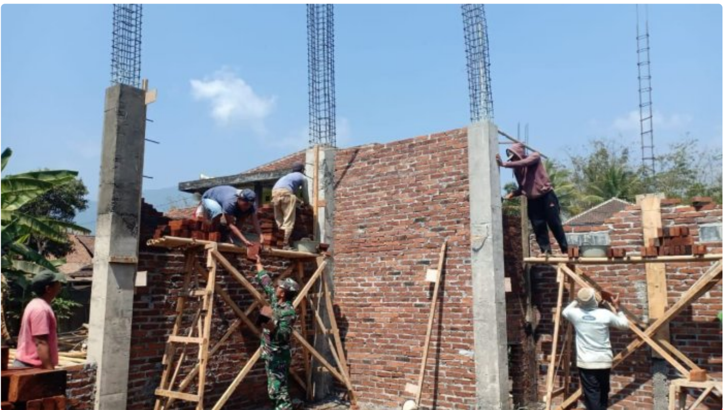
Anggota Koramil 04 Windusari Serda Nasikin kerja bakti bantu pembangunan Masjid
