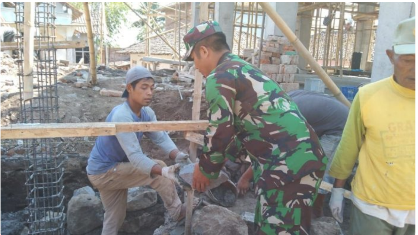
Serda Nasikin bantu pemasangan batu pondasi masjid
