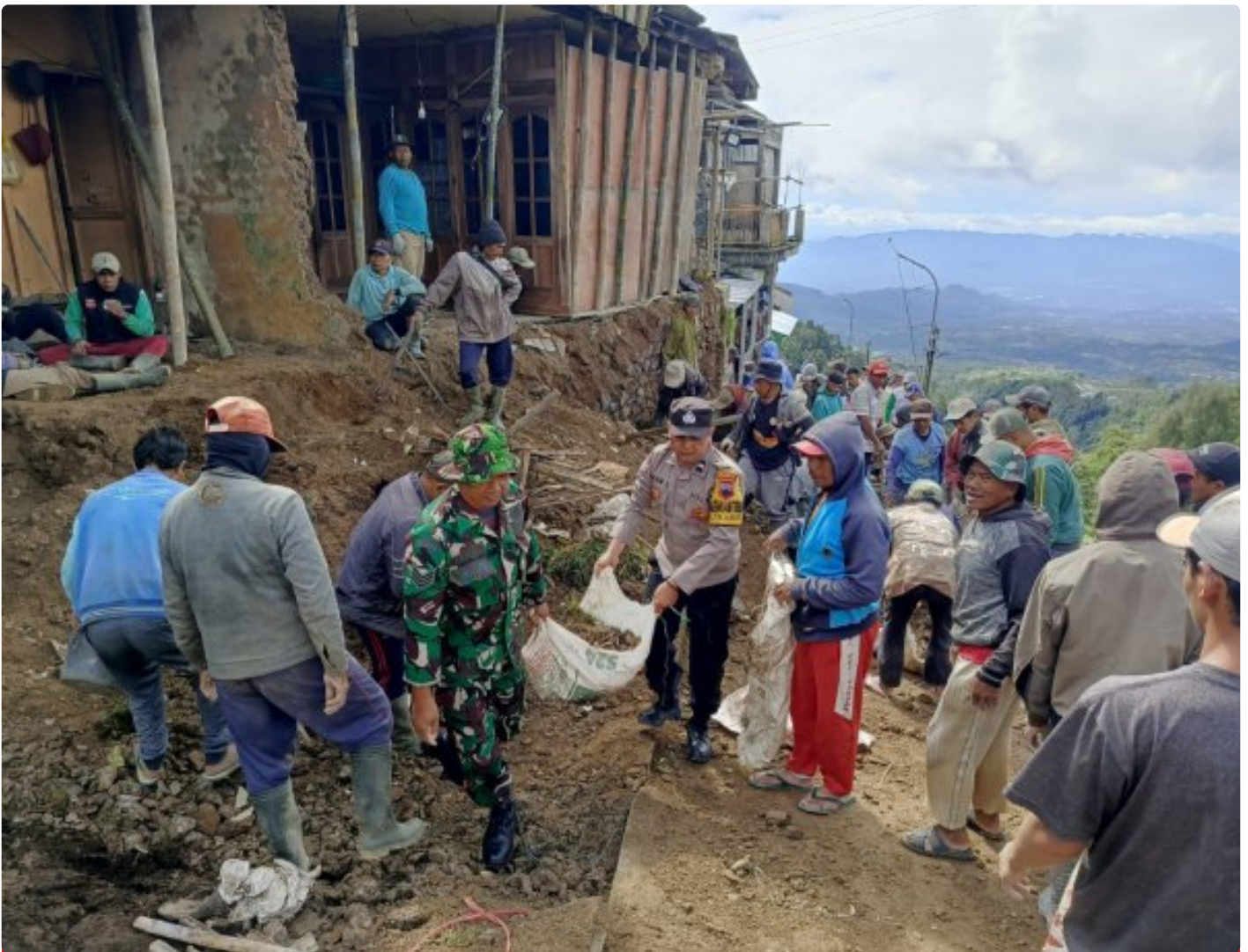
(Foto Dokumen) : Gotong royong pembersihan material longsor
