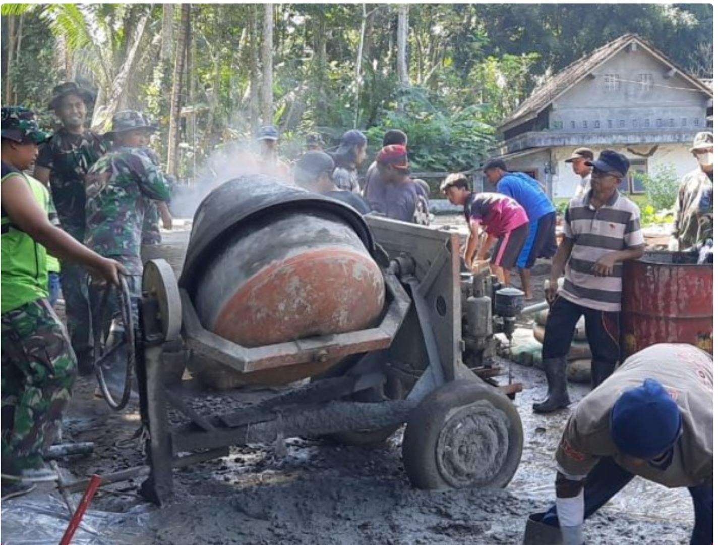
*(Foto Dokumen) : Pengerjaan cor jalan dalam rangka TMMD Sengkuyung Tahap II wilayah Kodim Magelang*
